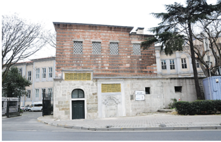
Zevki Hatun Sıbyan Mektebi Çeşmesi, Fındıklı'da Mimar Sinan Üniversitesi restorasyon laboratuvarı duvarında yer alıyor.
