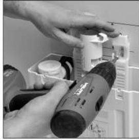
11 Tank ile birleştirilmiş braket bitmiş duvara sabitlenir.
