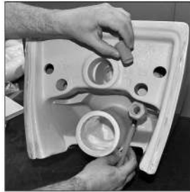
2 Montaj elemanının (1 ve 2) parçaları klozet montaj deliğinden geçirilerek birleştirilir.
