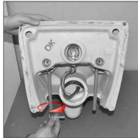
5 Allen anahtarı (5) sarı renkli borunun içerisinden geçirilip setskur gevşetilir.
