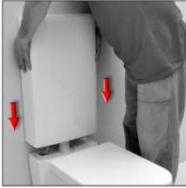
13 Rezervuar Braketin üst kısmındaki tırnaklara oturtulur
