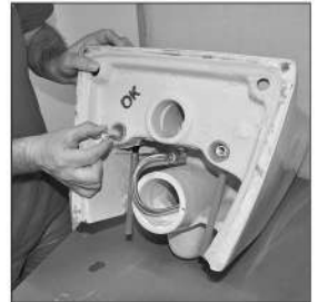
6 Setskur gevşetildikten sonra gömme rezervuar saplamalarına bağlanacak çelik parçalar (4) sökülür.
