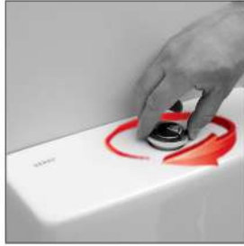
14 Basma butonunun montajı yapılır.
