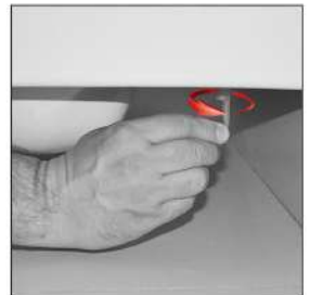
9 Klozet sarı borunun içerisinden geçirilen allen anahtarı ile sıkılır.
