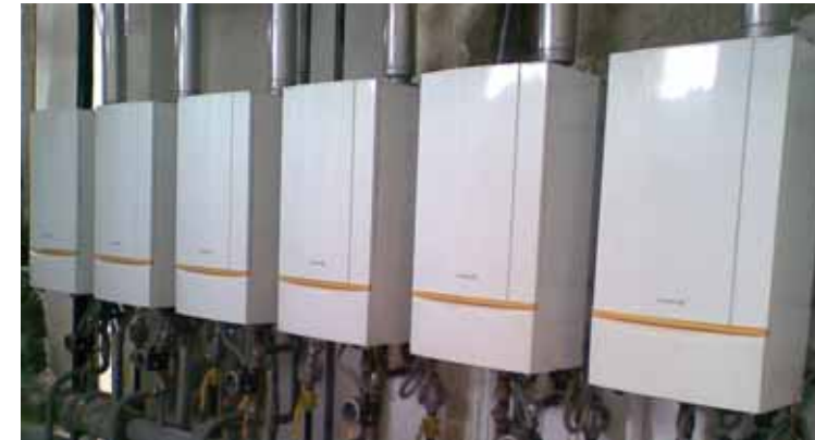
MC serisi duvar tipi yoğuşmalı kombilerde kendi aralarında bağlantı yapılan 10 cihazın birlikte çalışmasıyla 1140 kW'a kadar güç elde edilebiliyor.
